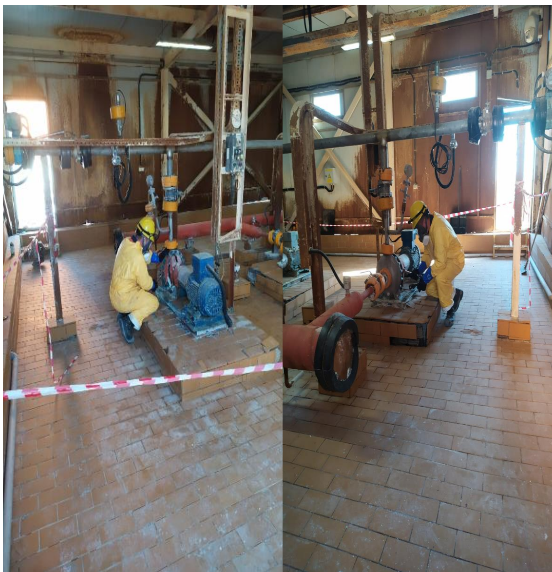
Рисунок 27 – Установка промежуточного фонаря на установку центробежного насоса
